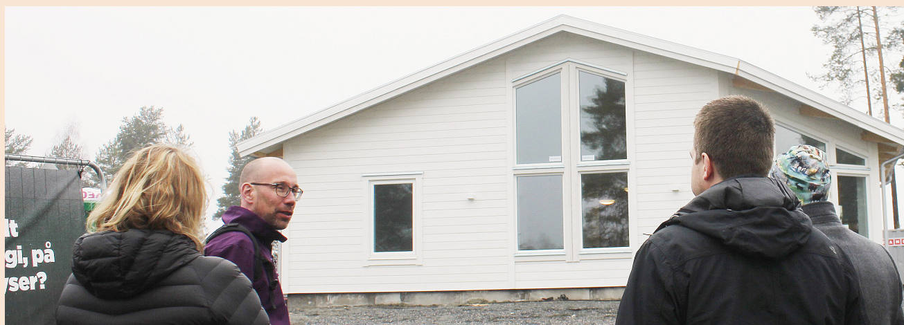
Zero Sun Project, Skellefteå Krafts nyinvigda villa som är självförsörjande på solenergi.
